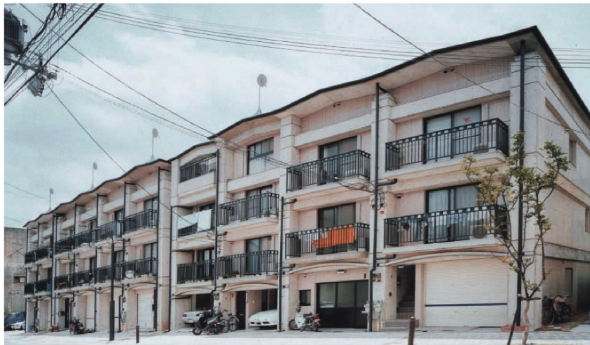
鷹取集合住宅:阪神淡路大震災後、初めて再建された長屋住宅。神戸街並み賞受賞。(設計:松原茂雄建築設計室)
