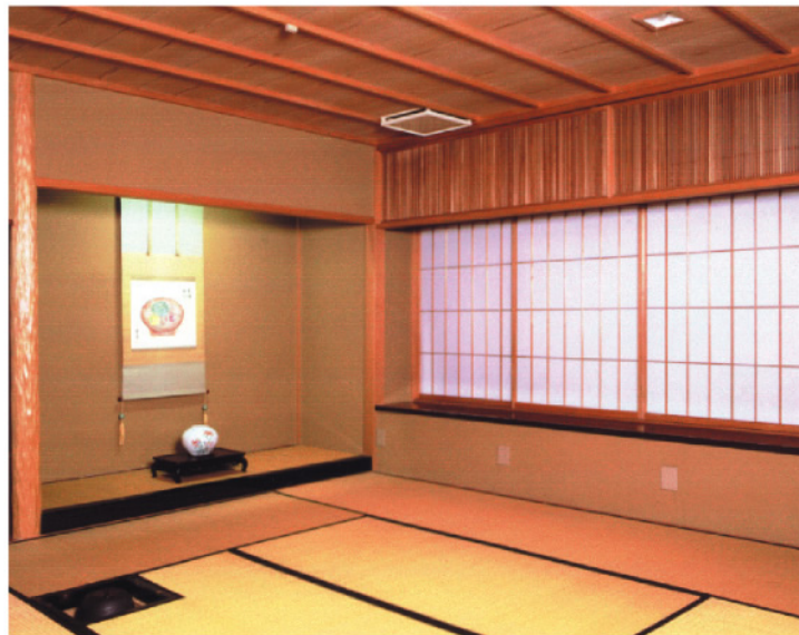
向井邸: 透かしの欄間・椋の床柱・春慶塗りの天板が特徴。(設計施工: 大美建築)
