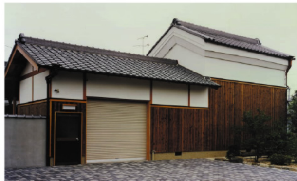
福井邸: 門屋と蔵を増築。(設計施工: 大美建築)
