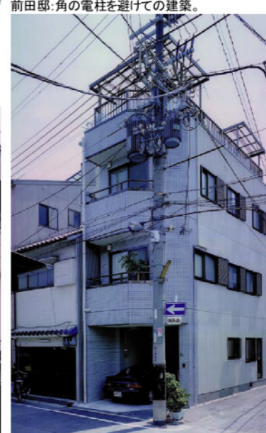
前田邸：角の電柱を避けての建築。
